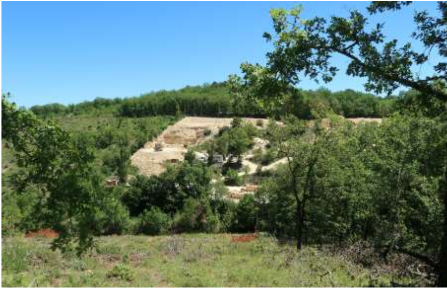
PL.2 : Perception visuelle proche depuis le chemin rural d'accès au site, en provenance du lieu-dit « Les Ygues »
