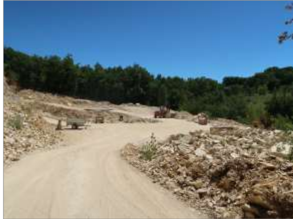
PL.10 : Vue de la plate-forme de triage et séchage
